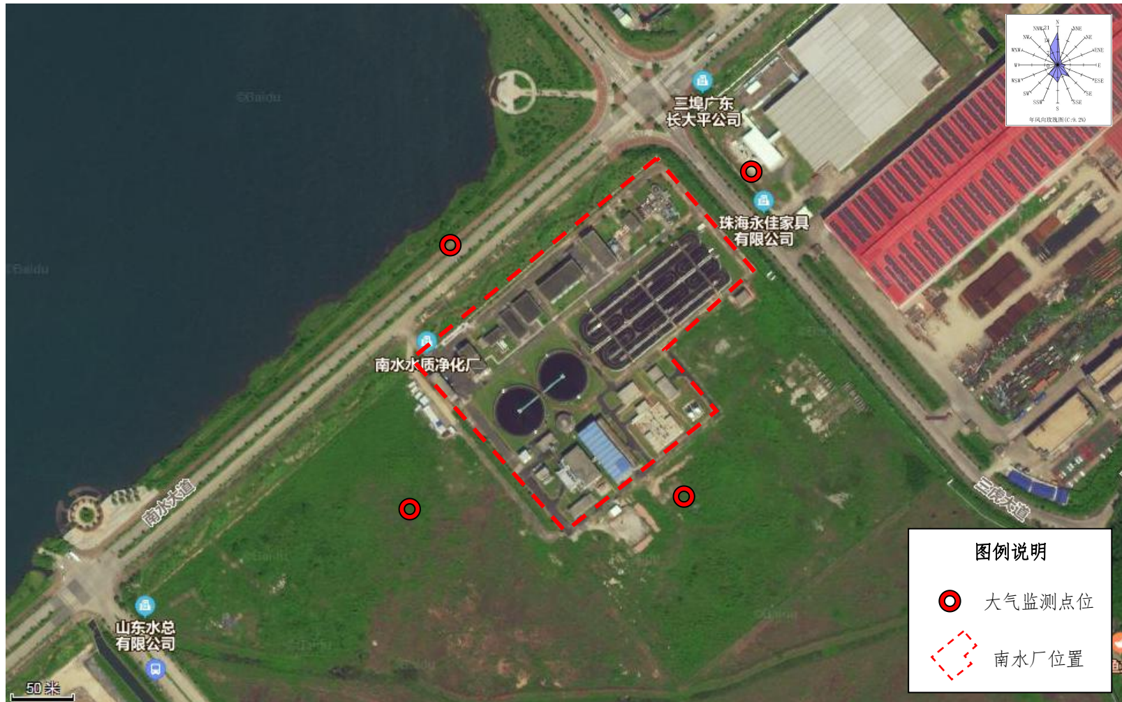
南水水质净化厂厂区大气监测点
